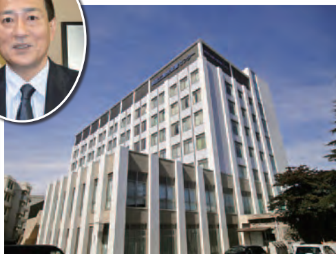
平成25年4月に竣工した新病棟
